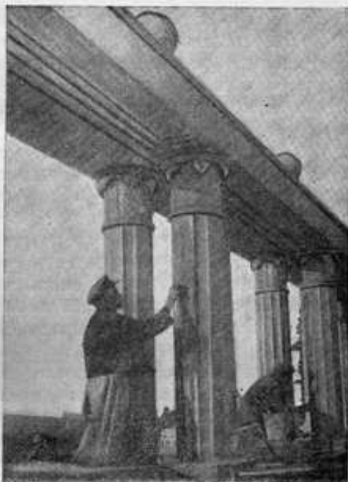
Шлифовка штукатурки колонн оселком.
